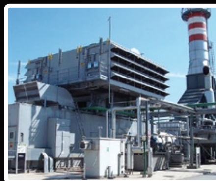
Elettrogorizia installazione LM6000 GE Elettrogorizia - Gas turbine installation LM6000 GE
