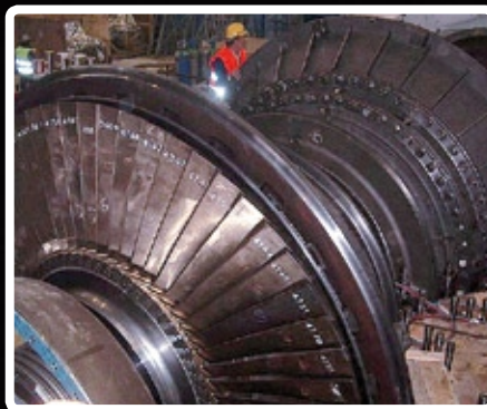
Termoli - installazione Tu Va Siemens ( turbina a vapore) Termoli - Steam turbine installation
