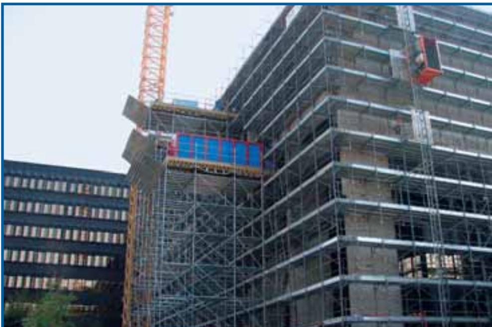
I piani di carico a sbalzo, utilizzati in abbinamento con i telai prefabbricati, arrivano a portate di 450 kg/mq. Possono essere semplici (180 cm x 180/250 cm) o composti (180 cm x 360/500 cm), per facilitare lo sfilamento della forca dai bancali portati in quota.
