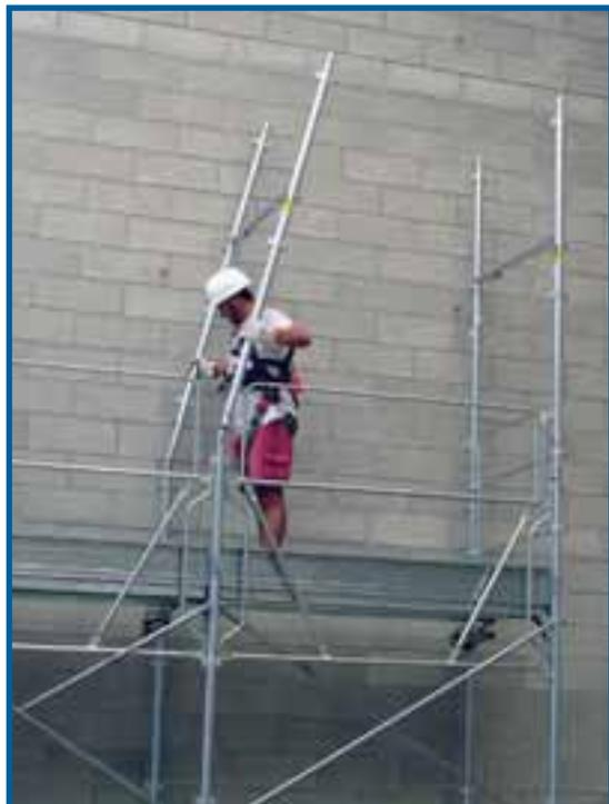
Montaggio del telaietto di parapetto
